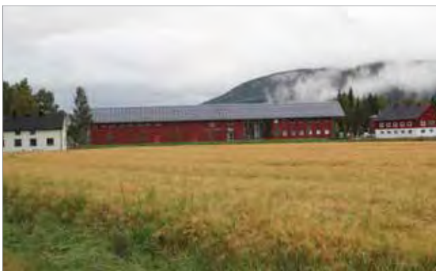
Hovedbygget på Campus Evenstad, også kalt lâven, har et soltak på 470 kvadratmeter. Det produserer rundt 64 000 kWh i året og blir en viktig del av Campus Evenstad Energy Center, CEEC, som nå bygges opp.
