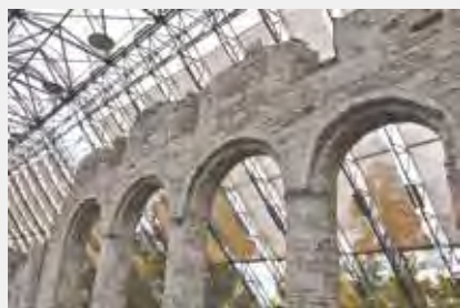
Et vernebygg av glass og stål beskytter de vakre ruinene. Det stod ferdig i 1998.
