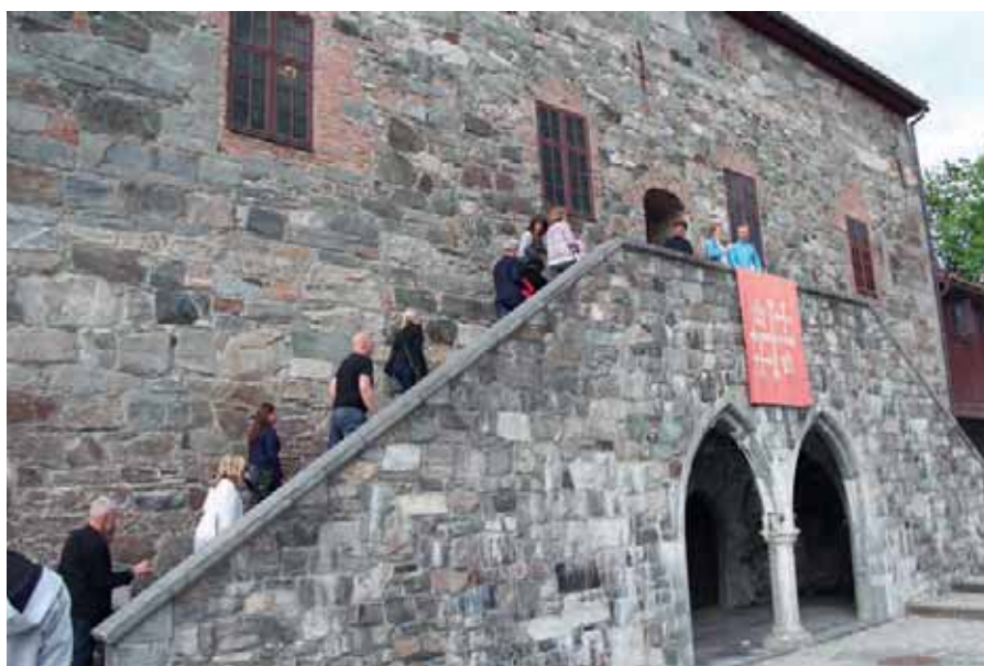
En utvendig trapp til erkebiskopens hall er rekonstruert etter gamle tegninger.
