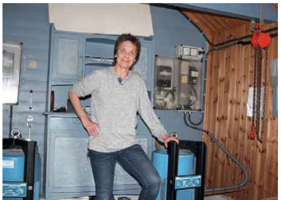
Faren til Kristin Sørheim fikk bygd to mikrokraftverk på gården. Her viser hun fram turbinene i et av kraftverkene som samlet produserer 300 000 kWh i året.
