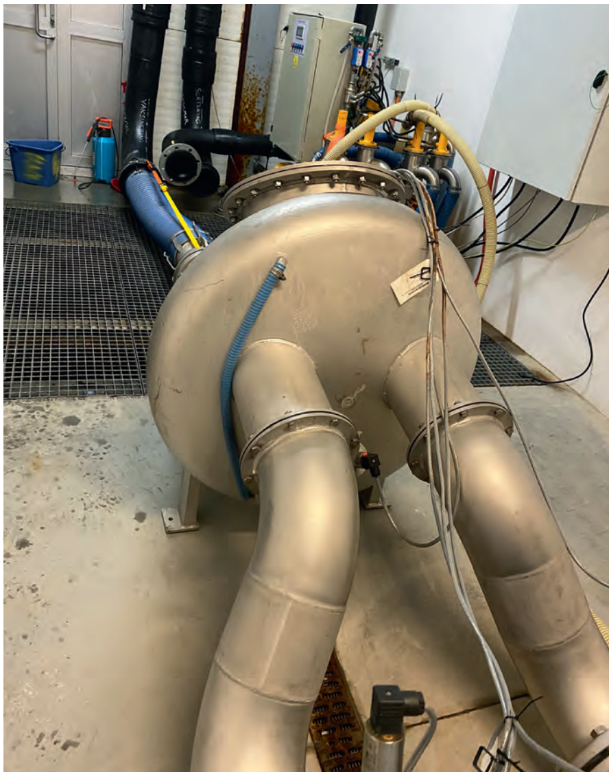
Grundig vask og desinfeksjon av vakumtanker (bildet), vaksinerings- og sorteringsmaskiner er også nødvendig for å bli kvitt poxvirus, men dagens utforming av maskinene gjør at dette kan være komplisert å få til.
